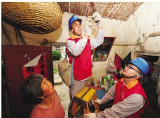
▲志愿服务队为贫困户安装照明线路
